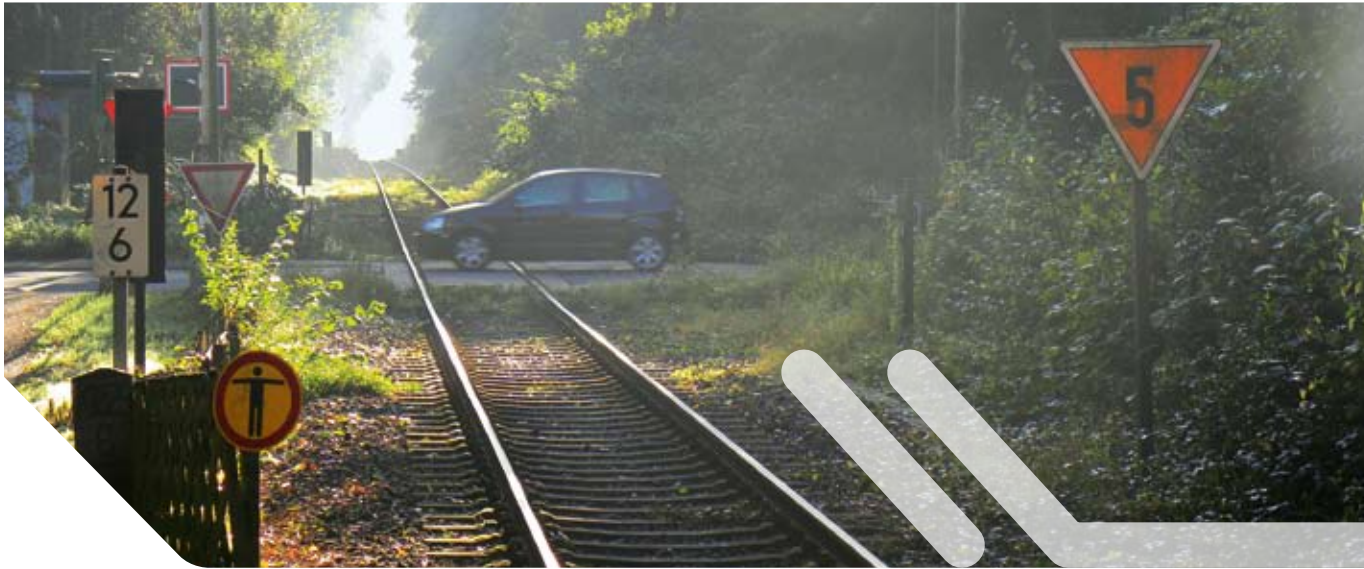
Das Langsamfahrtsignal kündigt beim Haltepunkt Do-Lütgendortmund Nord die Langsamfahrstelle zwischen km 12,9 und km 13,3 mit 50 km/h an
