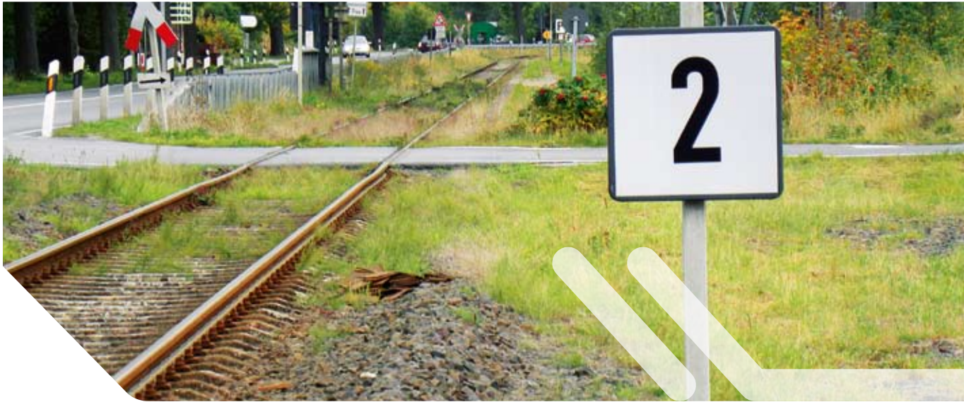
Technisch nicht gesicherter Bahnübergang bei Raestrup-Everswinkel, der nur noch mit 20 km/h befahrbar ist
