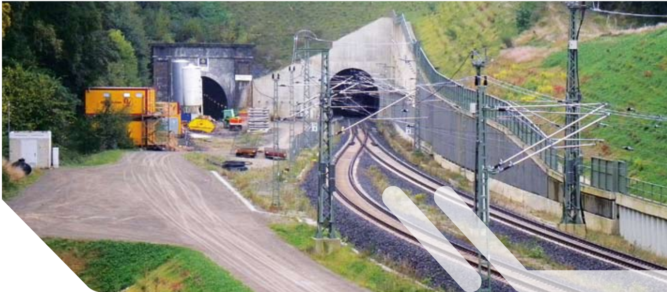
Links ist der alte Buschtunnel zu sehen, der zur Zeit saniert wird; rechts die neue Tunnelröhre
