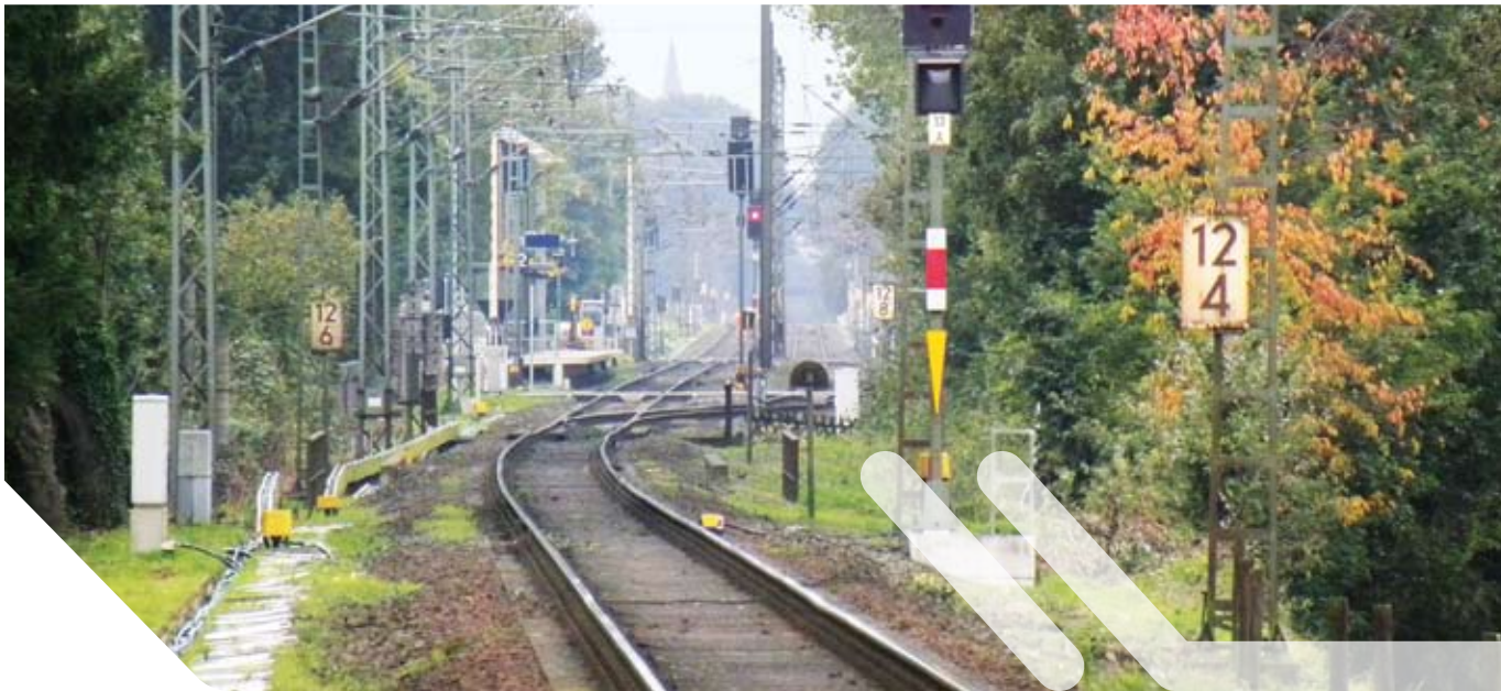
Blick auf die Einfahrt in den Bahnhof Breyell. Bereits 1996 konnte die Brücke nur mit 90 km/h befahren werden (vor der ersten Weiche)
