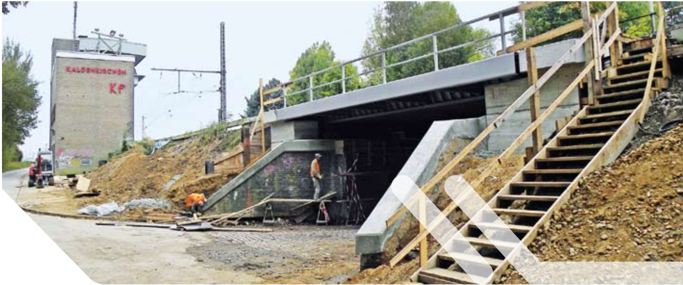
Brückenarbeiten bei km 18,5 (mängelbedingte Langsamfahrstelle von max. 20 km/h)
