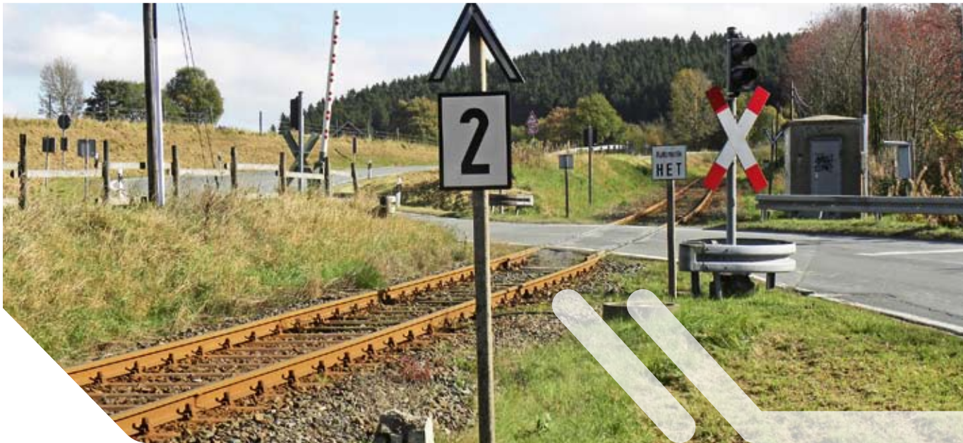
Beginn der ständigen Langsamfahrstelle (Bahnübergang bei km 24,8), die mit maximal 20 km/h zu befahren ist
