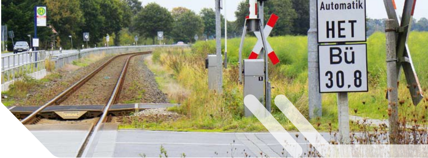
Mit Halbschranken und Lichtzeichen gesicherter Bahnübergang im sanierten Abschnitt zwischen Warendorf und Beelen
