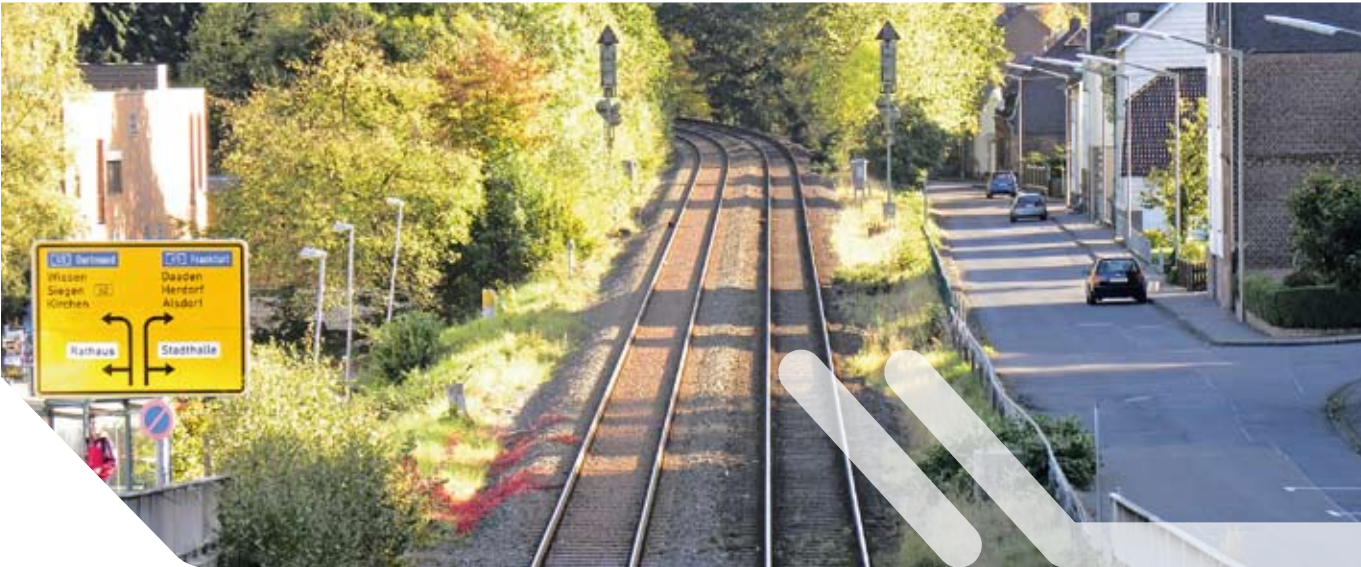
Blick von der Straßenüberführung bei km 83,4 in Richtung Grünebächerhütte. Das rechte Gleis im Bild gehört zur Daadetalbahn (Strecke 9288)
