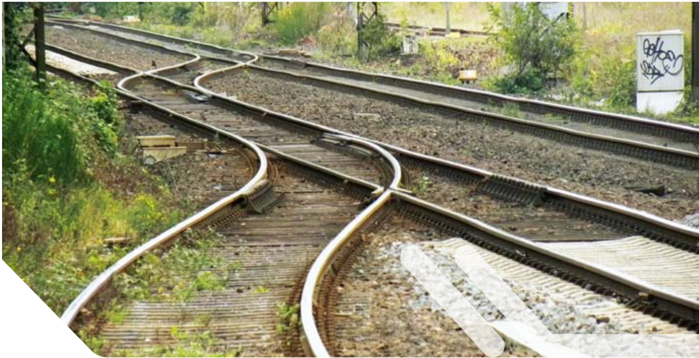
Streckenübergang bei Du-Bissingheim von Strecke 2326 auf 2324
