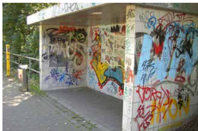
Mit Graffiti verschmutzter Wetterschutz in Hagen-Westerbauer
