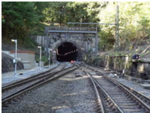
Der Rehbergtunnel wurde im Sommer 2013 saniert und ein jahrelanger Engpass somit beseitigt.
