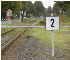
Langsamfahrstellen (wie hier an Bahnübergängen) können durch Fahrzeitverluste den Betriebsablauf erheblich beeinträchtigen.
